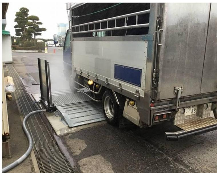
Gambar 2: Contoh kemudahan *Vehicle dip* / *Vehicle spray* di pintu masuk ladang penternakan
